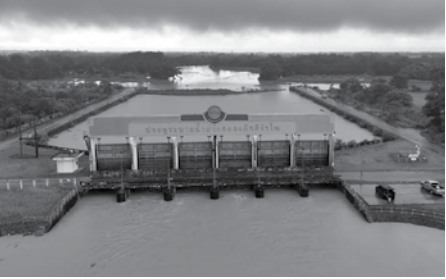
ประตูประทายน้ำปากคลองภักดีรำไพ จ. จันทบุรี
